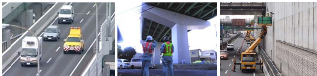
日常点検（路上点検）
