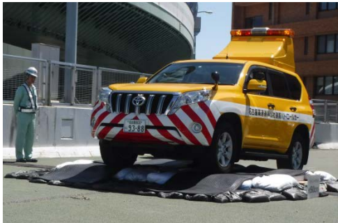
《軽量渡し板の設置訓練》
