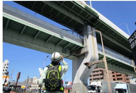
《路下点検実働訓練》
