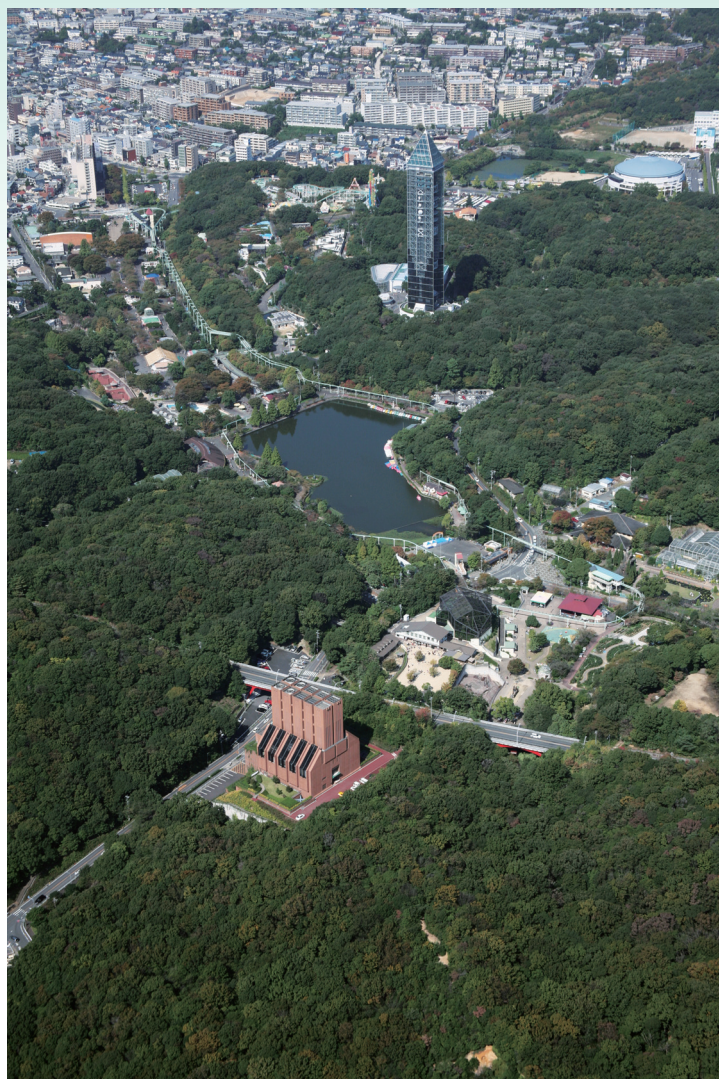
高速2号東山線 緑橋換気所と東山スカイタワー
