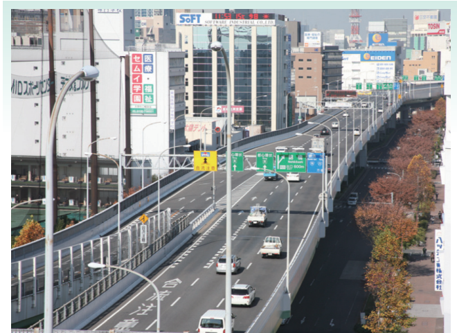
新洲崎 JCT 合流部
