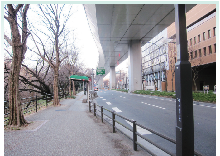
高速都心環状線と外堀通り本町橋付近
