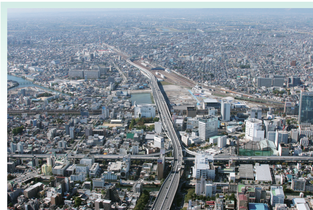
新洲崎 JCT から高速 5 号万場線方面を望む
