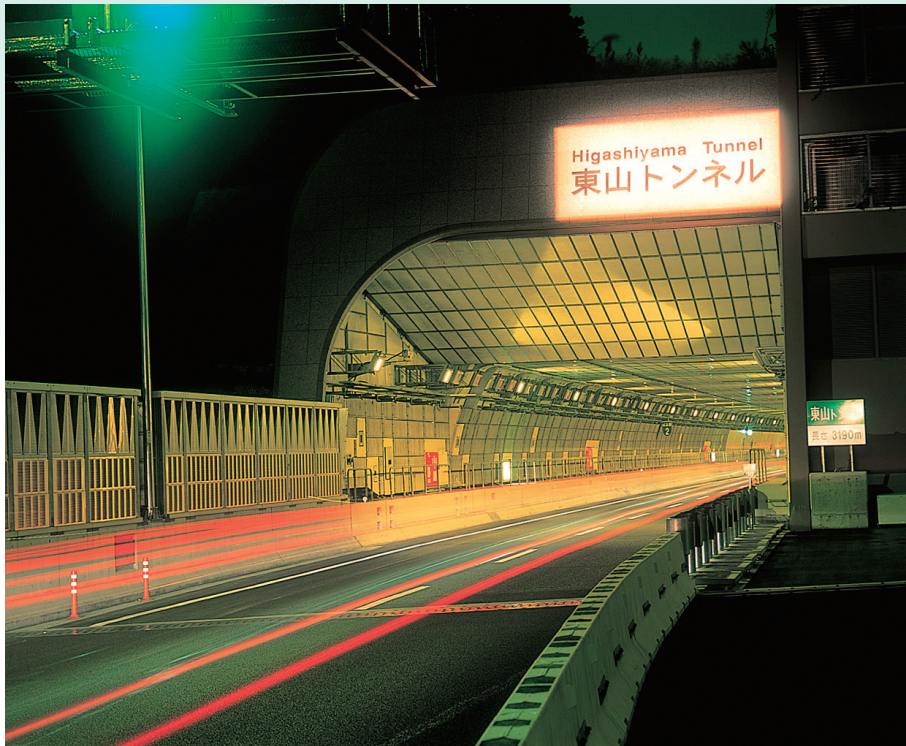
高速2号東山線 東山トンネル
