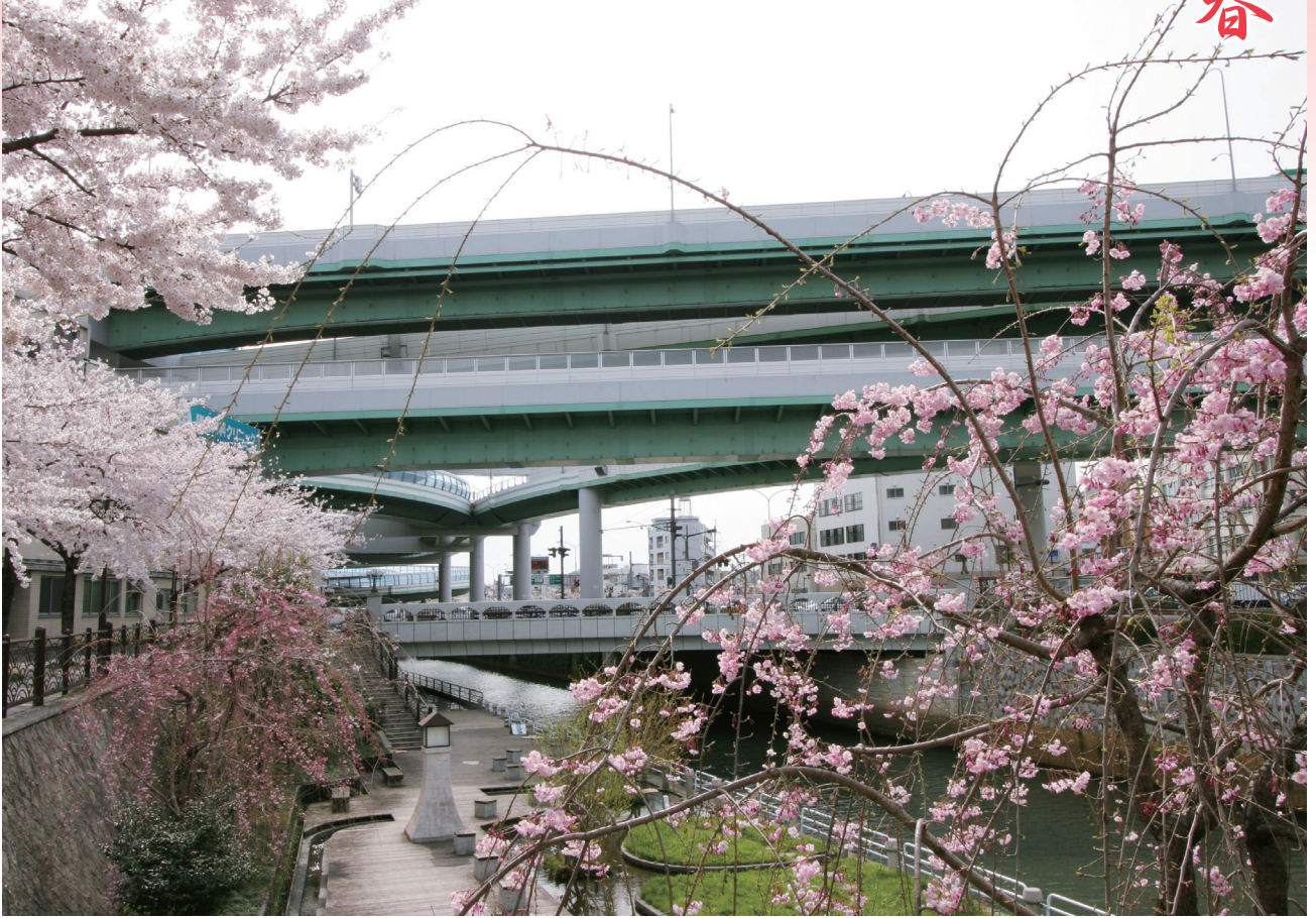
高速 1 号楠線 黒川出入口付近の堀川親水護岸
