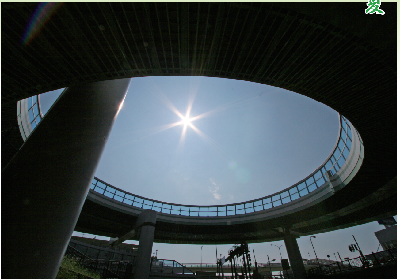
高速 1 号楠線 黒川出入口西ループ
