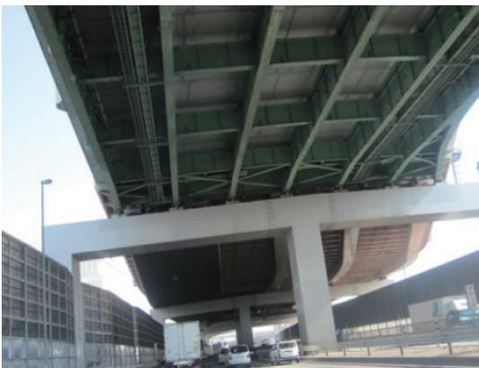
写真 3-1-6 鋼・コンクリート合成床版
