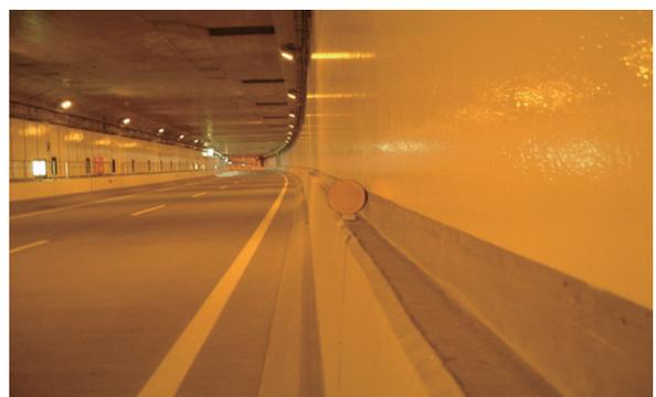
写真 3-5-4 東山トンネル右側のコンクリート壁面（セラミック系無溶剤塗料の採用）
