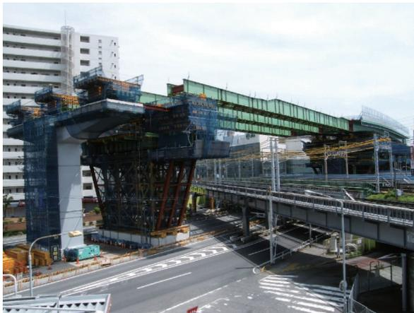
写真 3-9-3 鉄道立体交差部の架設
