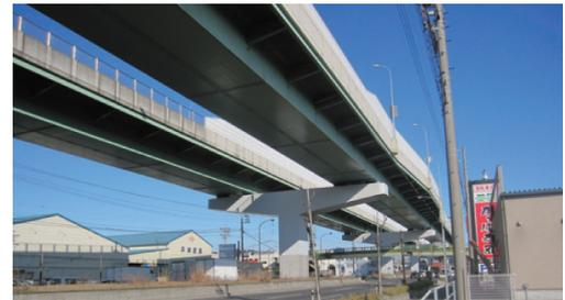
写真 3-6-1 上下線分離構造の高速小牧線
