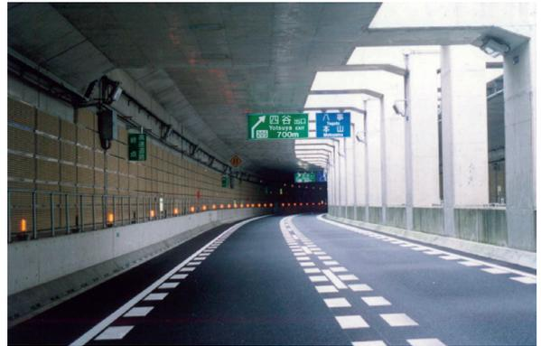
写真 3-5-3 半地下区間における壁面吸音板の設置
