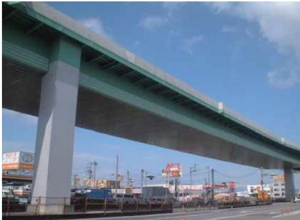
写真 3-8-3 古城交差点付近の高架裏面吸音板
