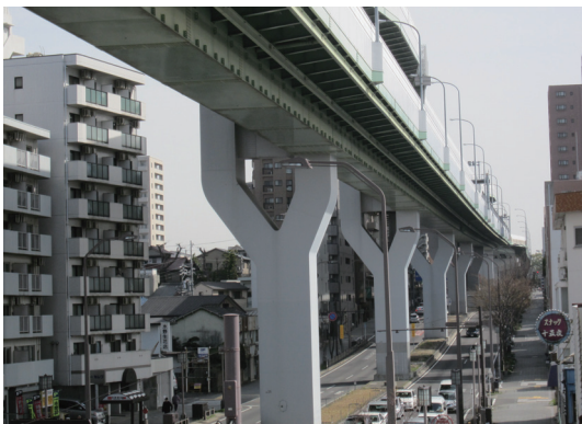
写真-3 高速1号楠線 Y 型2層構造
