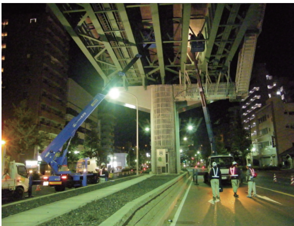
写真 6-3-1 高所作業車を用いた目視点検
