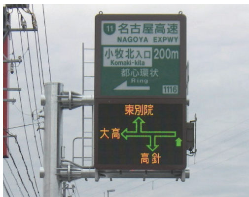
写真 6-5-4 入口誘導案内標識（改良後）
