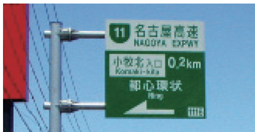
写真 6-5-3 入口誘導案内標識（改良前）
