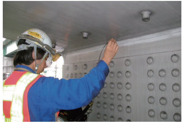
写真 6-3-2 鋼製橋脚の隅角部の点検
