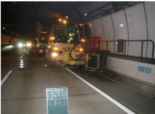
写真 6-2-5 トンネル壁面清掃
