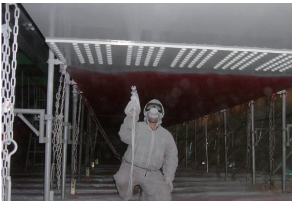
写真 6-4-1 高塗着スプレー塗装
