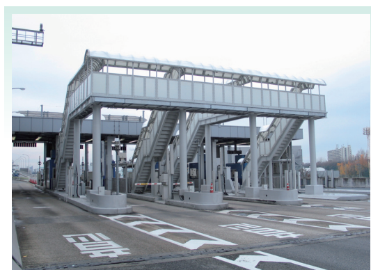
料金収受員専用歩道橋 (星崎料金所)
