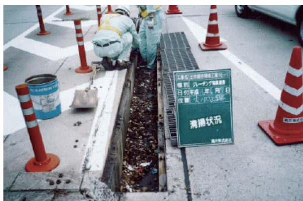
写真 6-2-2 側溝清掃
