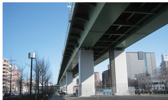
写真 7-6-3 高速 2 号東山線（新洲崎 JCT ～丸田町 JCT）
