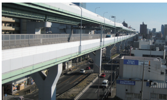
写真 7-6-2 高速 1 号楠線（清水口～黒川出入口）
