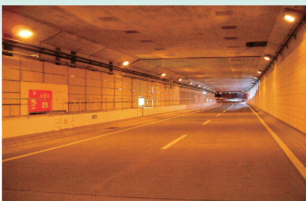
高速2号東山線 壁面吸音板と低騒音舗装 （東山トンネル四谷入口手前）
