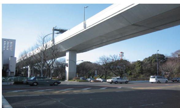
写真 7-6-1 高速都心環状線（明道町 JCT ～東片端 JCT）
