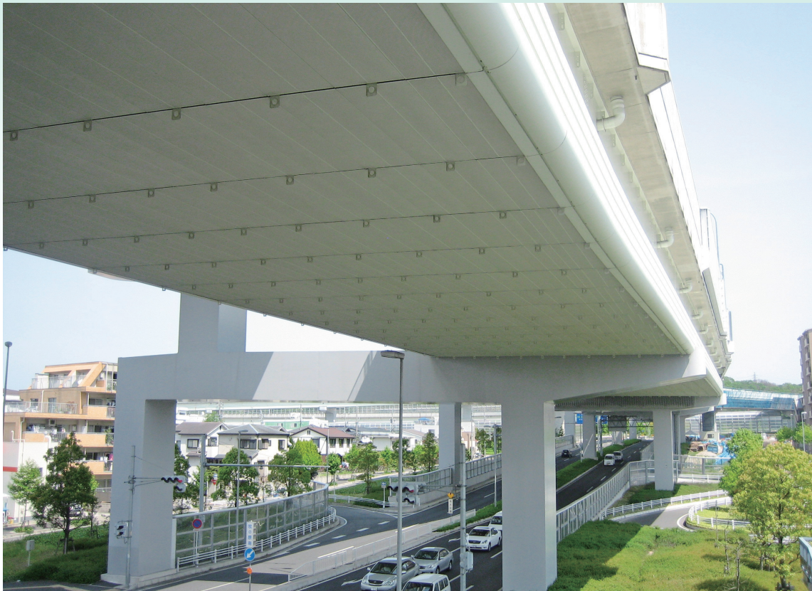
高速 2 号東山線 高針 JCT の高架裏面吸音板と環境施設帯
