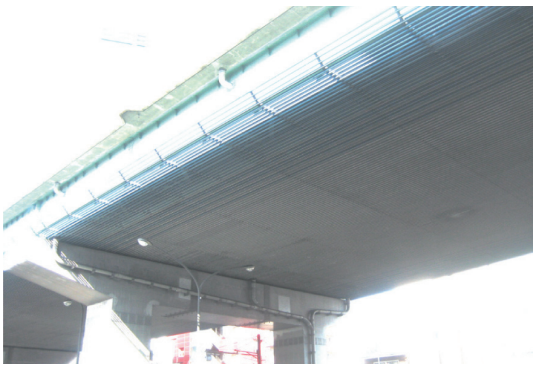
写真 7-6-6 東新町入口付近の桁下ルーバー
