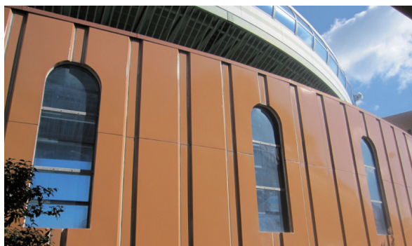
写真 7-6-11 同出入口西ループの5m 遮音壁
