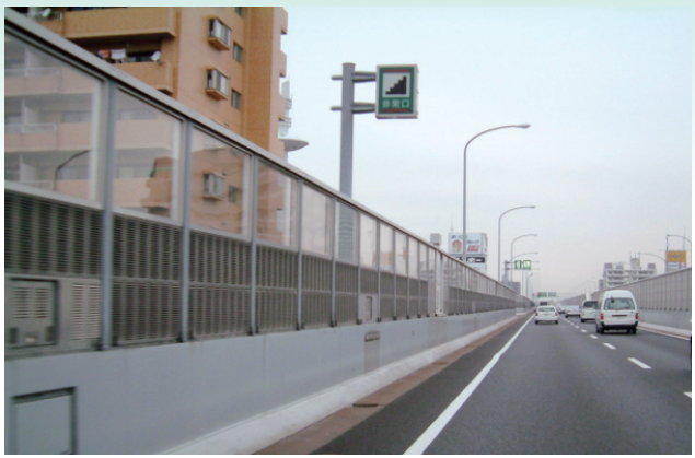
低騒音舗装の敷設と遮音壁の嵩上げ（高速1号楠線）
