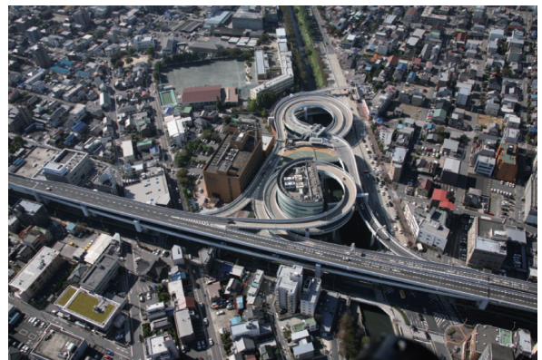
写真 7-6-7 高速1号楠線黒川出入口
