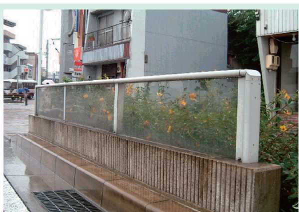
市道鏡池線沿線の低層遮音壁（透光タイプ） （高速 2 号東山線 半地下構造区間）
