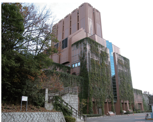
写真 7-6-14 壁面緑化（緑橋換気所）
