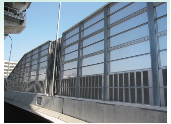
4m 遮音壁（高速4号東海線 木場入口）
