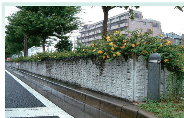
市道鏡池線沿線の低層遮音壁（花壇タイプ） （高速 2 号東山線 半地下構造区間）
