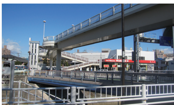
写真 7-6-10 同出入口のエレベーター付き立体横断施設
