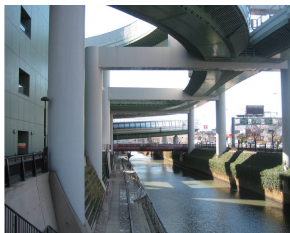
写真 7-6-16 親水護岸（堀川）
