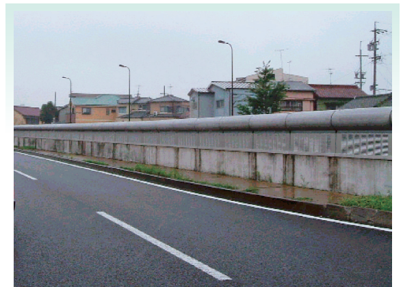
高速2号東山線 先端改良型遮音壁
