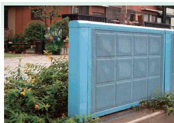
市道鏡池線沿線の低層遮音壁（吸音タイプ） （高速 2 号東山線 半地下構造区間）
