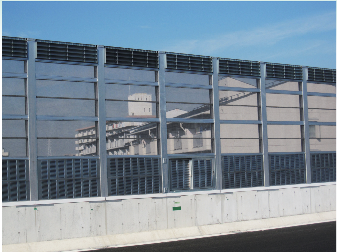
先端改良型4m 遮音壁（高速4号東海線 木場付近）
