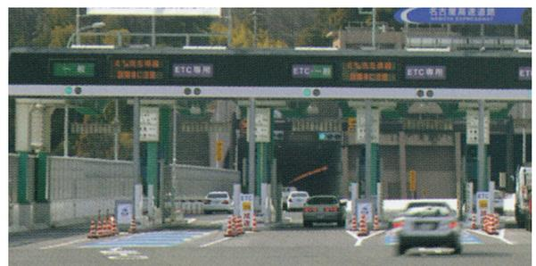
写真 9-1-3 薄層カラー舗装による ETC レーンの表示 (高針料金所)
