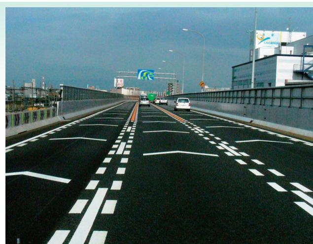
路面標示による速度抑制（山王 JCT）
