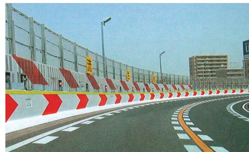
写真 9-1-2 矢羽根マーク等の施工 (明道町 JCT)
