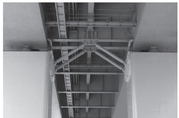
写真 10-1-6 座屈拘束ブレース
