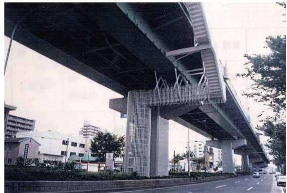
写真 10-1-2 高架下の非常階段出口
