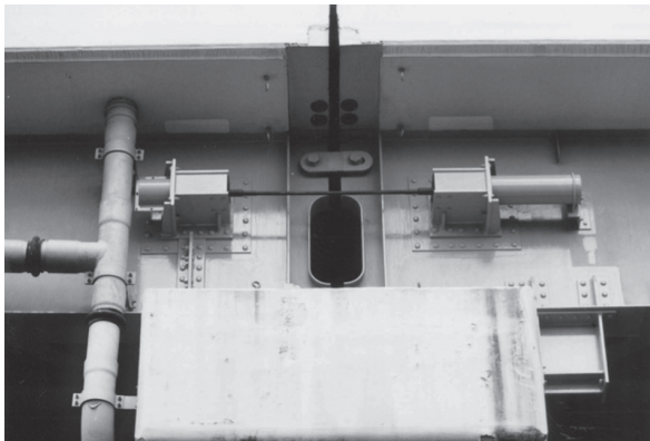
写真 10-1-5 落橋防止装置（PC ケーブル）
