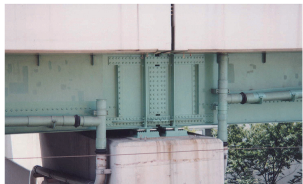
写真 10-1-3 桁の連続化
