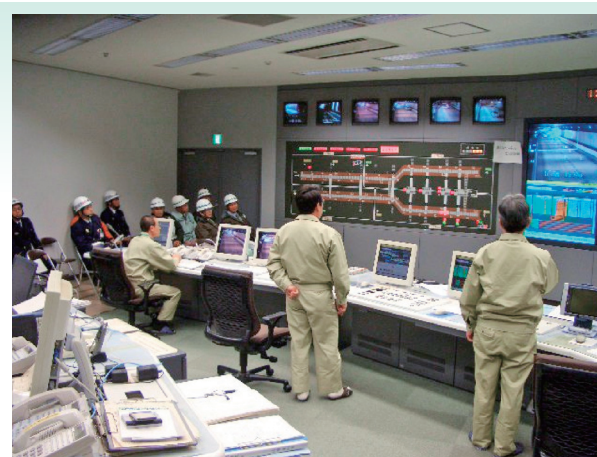
訓練状況の把握（緑橋換気所施設管制室）
