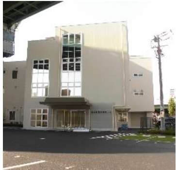
図29 整備部社屋改修状況 増築部分の工事完了 (令和2年8月末)
