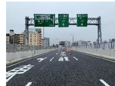
図40 リフレッシュ工事の完了
