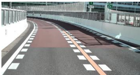
図17 東片端JCT北カーブのカラー舗装
