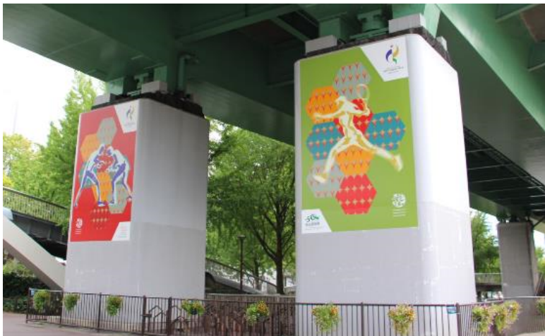
図6 橋脚ラッピングアートの実施状況 (若宮大通公園〔矢場町交差点〕)
