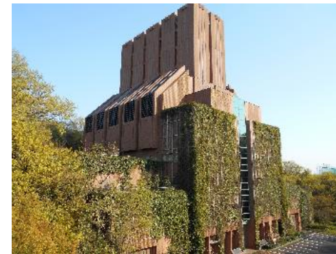
図45 緑橋換気所(東山公園内)の壁面緑化
