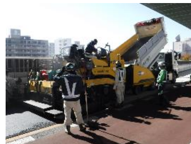
図39 アスファルト舗設の状況
