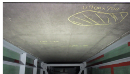
図36 コンクリート床版下面(補強前)
