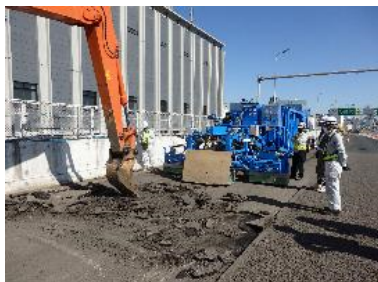
図38 舗装撤去の状況
