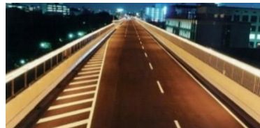
ヒメボタルの保護を目的としたパイプ照明設置状況
