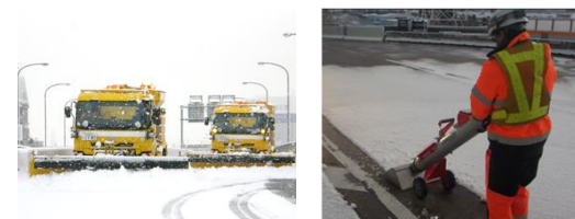
除雪作業の状況
