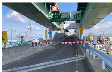
入口閉鎖装置設置例
