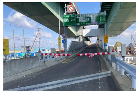
入口閉鎖装置（高速16号一宮線西春入口）
