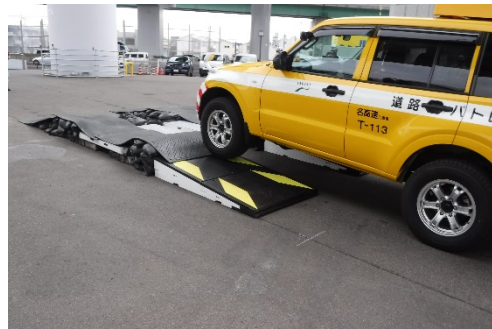
《軽量スロープによる段差応急復旧》
