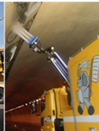
《トンネル灯具清掃での使用状況》
