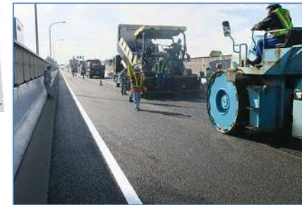
3号大高線リフレッシュ工事 (高機能舗装の打ち換え)
