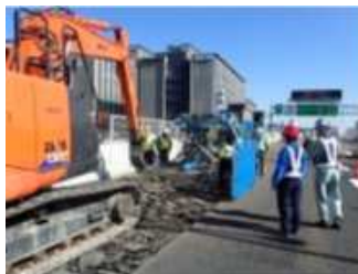
リフレッシュ工事
