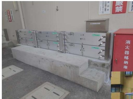
受変電施設の止水板設置例
