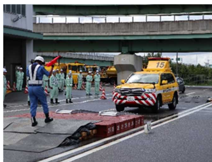
《軽量スロープによる段差応急復旧》
