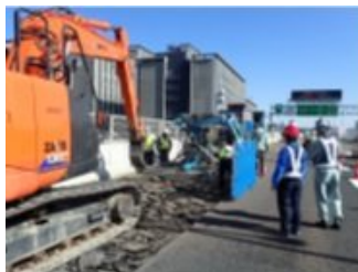
リフレッシュ工事
