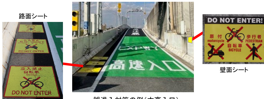
誤進入対策の例(大高入口)
