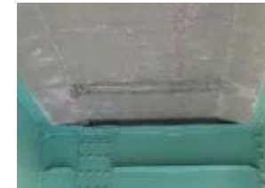
コンクリート床版の損傷状況
