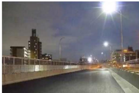
LED照明（本線上）
