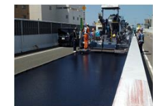
アスファルトの舗設
