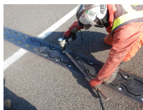
伸縮装置の修繕
