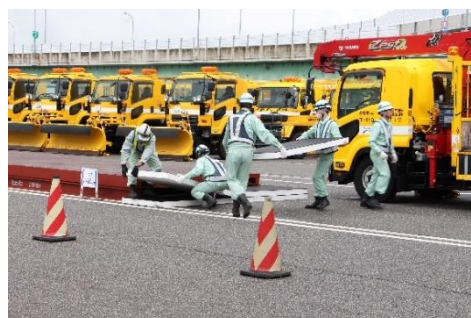
《軽量スロープによる段差応急復旧》
