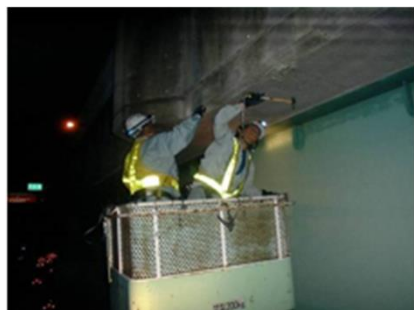
高所作業車による打音検査の状況
