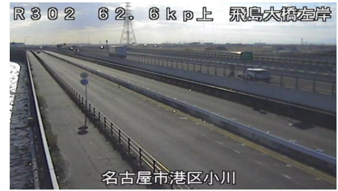
国道302号飛島大橋（渡河部の橋梁）
