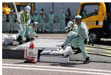
《軽量渡し板による損傷の応急復旧》
