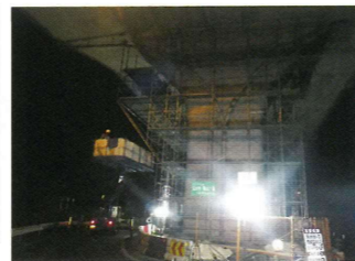
足場の撤去作業
