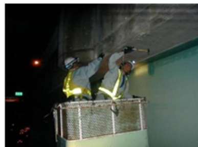
高所作業車による打音検査の状況
