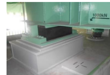
応急復旧 ジャッキの規格や据付け位置の明示
