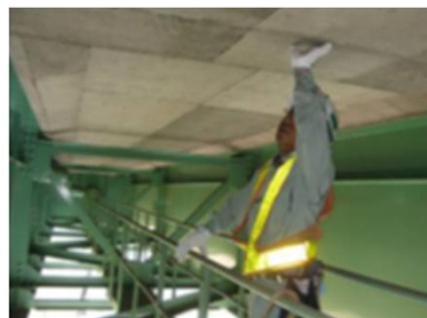
検査路における近接目視点検の状況
