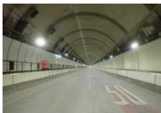
高速2号東山線 東山トンネル
