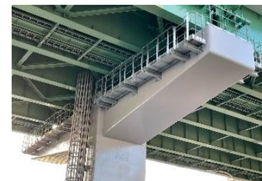
緊急点検 橋脚梁周りの検査路の整備
