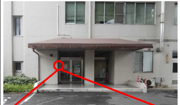
【星崎ビル正面入口】
