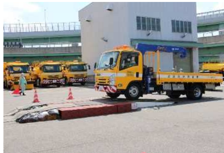
《軽量スロープによる段差応急復旧》
