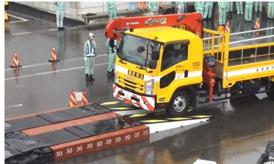
《軽量スロープによる段差応急復旧》
