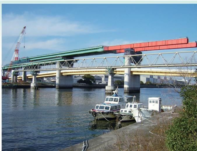
高速4号東海線 きらく橋（堀川）上の送り出し架設工事
