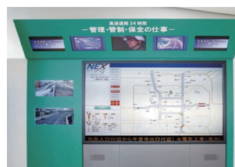
交通状況表示パネル
