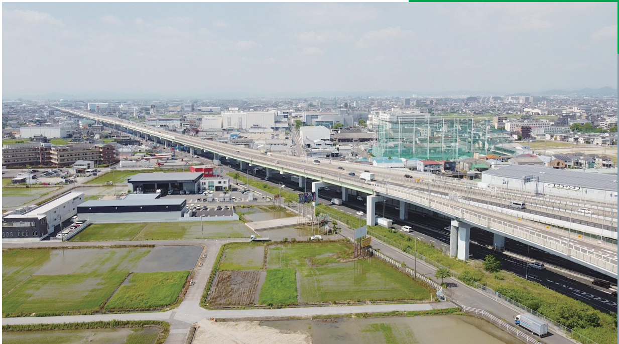
高速16号一宮線 清洲JCT付近から一宮方面を望む
