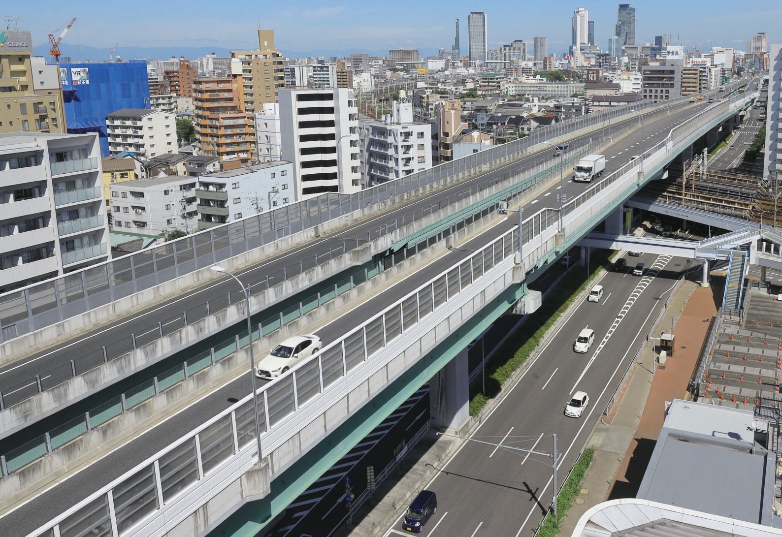
高速4号東海線 尾頭橋から都心方面を望む
