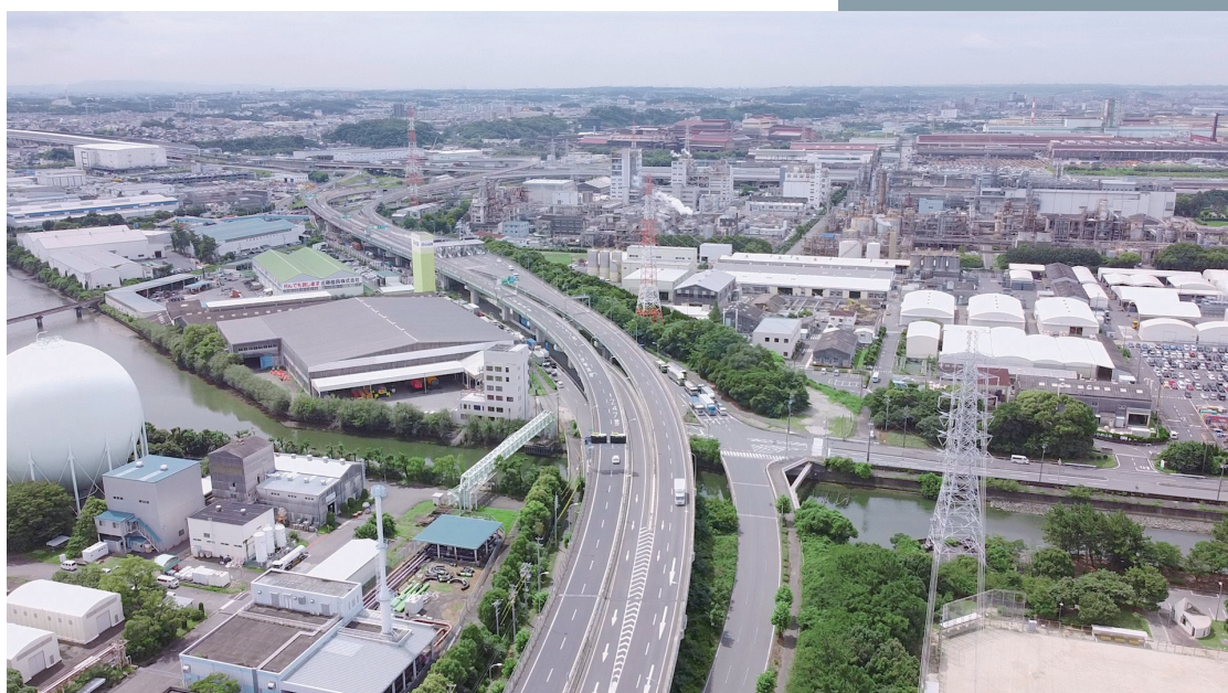
高速4号東海線 東海新宝から東海JCT方面を望む
