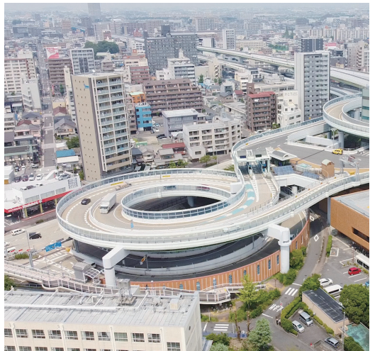
高速1号楠線 黒川出入口
