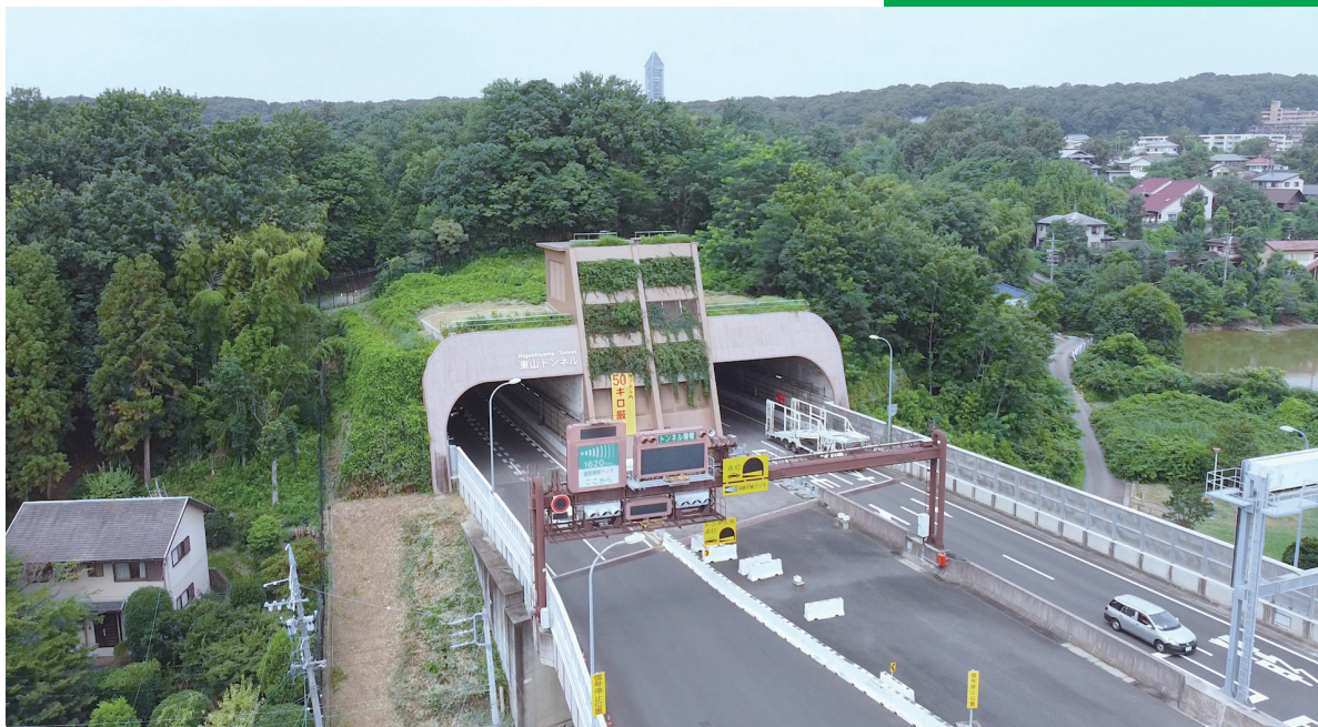
高速2号東山線 東山トンネル出入口
