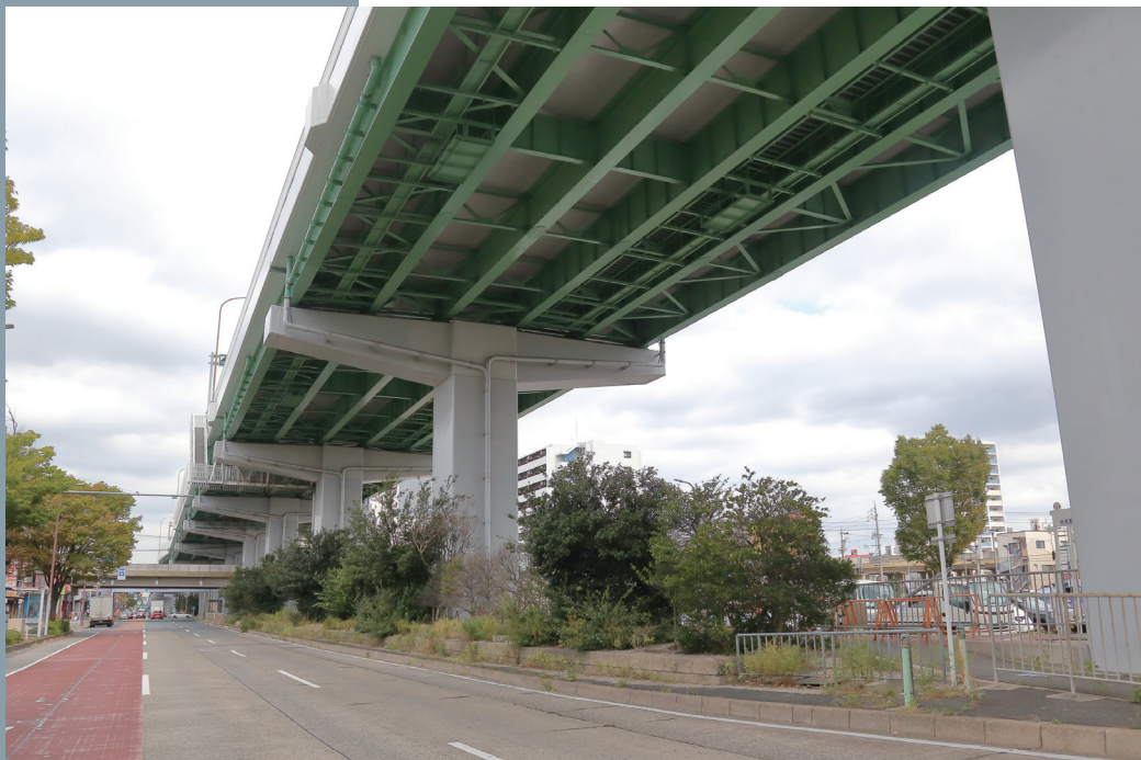
高速3号大高線 堀田付近
