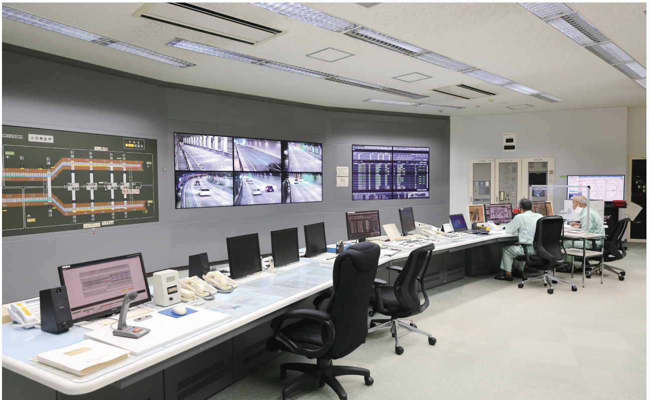
高速2号東山線 施設管制室
