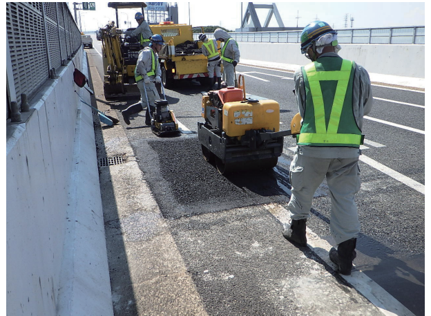
写真3-2-9 舗装補修作業の状況
