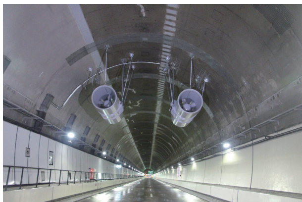
写真3-2-5 ジェットファンの設置状況
