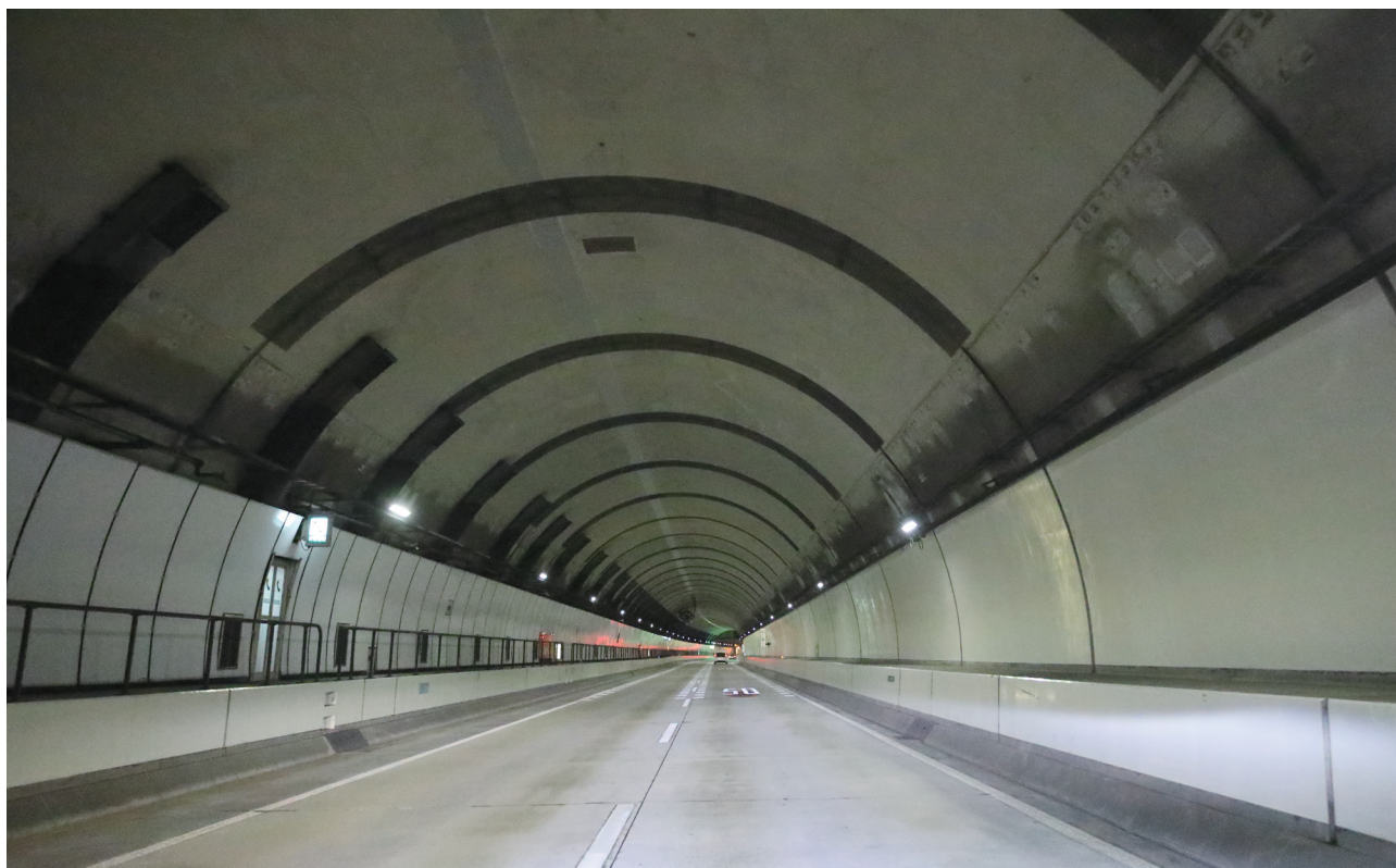
高速2号東山線 東山トンネル（トンネル天井板撤去後）
