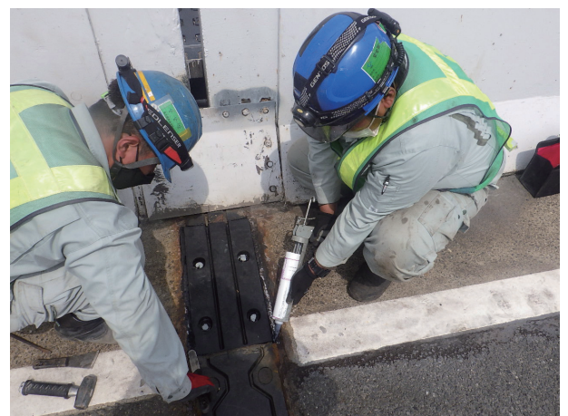
写真3-2-6 伸縮装置補修作業の状況
