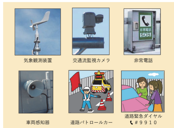
図3-1-1 交通管制室情報機器等一覧
