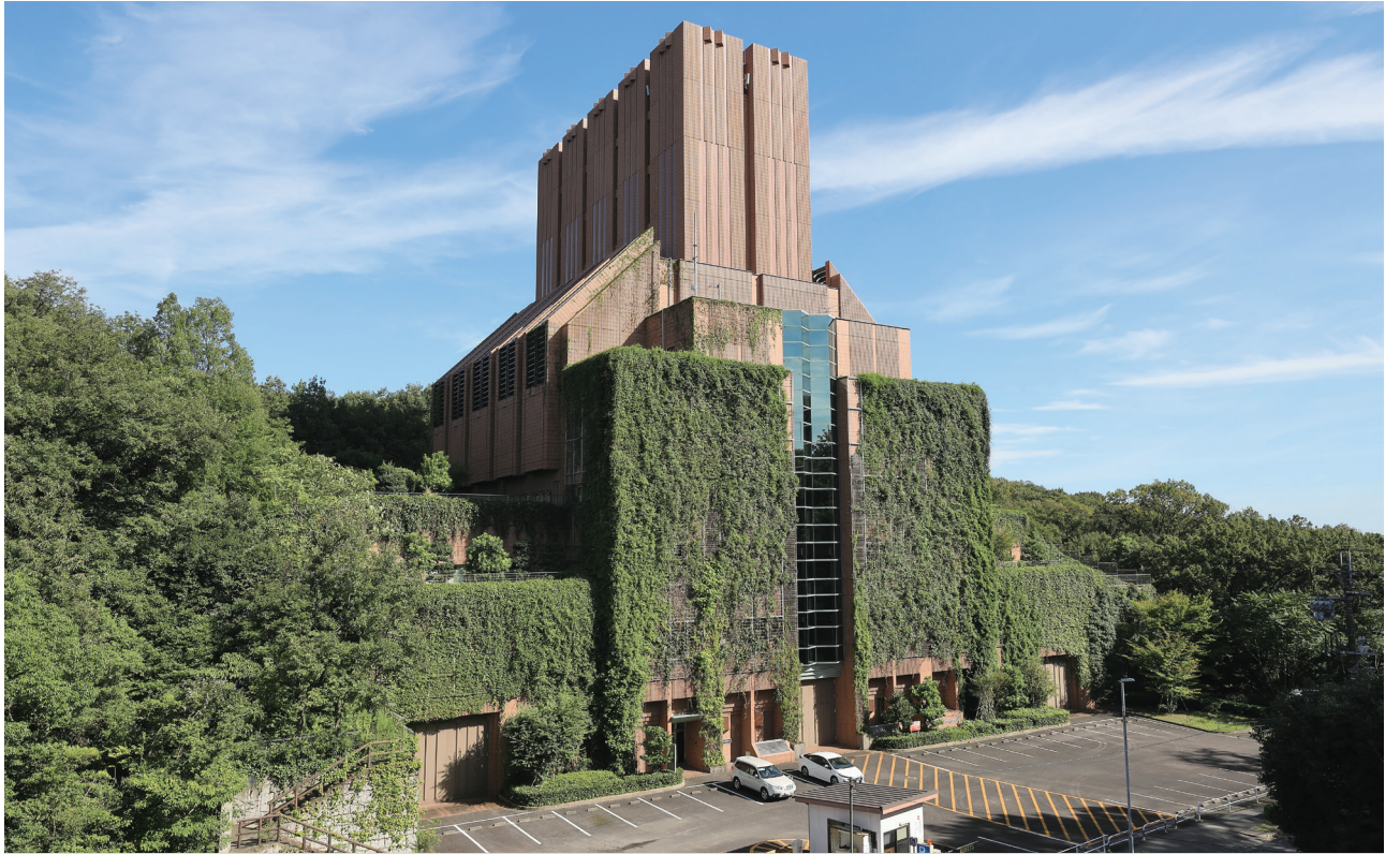
高速2号東山線 緑橋換気所
