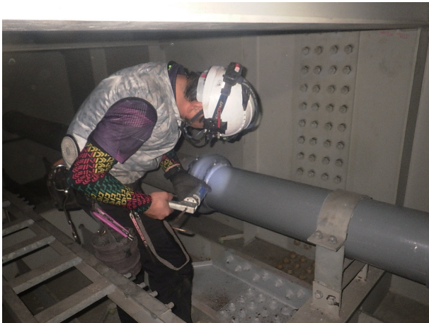
写真3-2-7 排水管補修作業の状況
