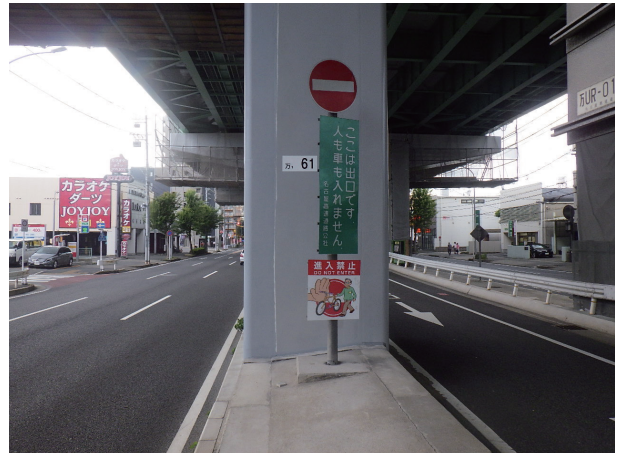
写真3-2-2 進入禁止イラスト入り看板など逆走対策
