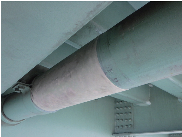
写真3-2-8 漏水補修完了後の状況
