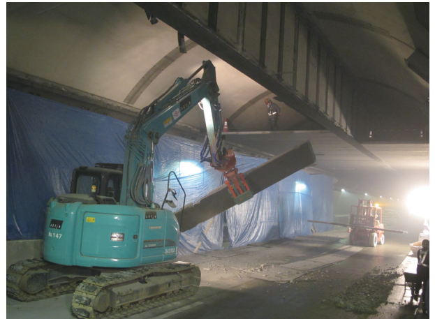
写真3-2-4 天井板撤去工事の現場
