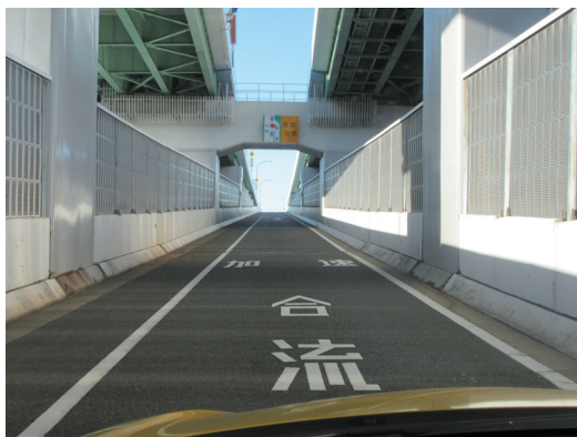
写真3-2-3 笠寺入口合流部の安全対策
