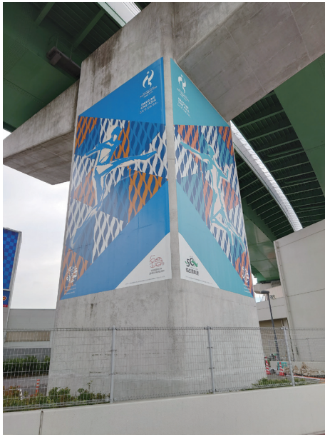
写真4-1-4 橋脚ラッピングアート（港明）
