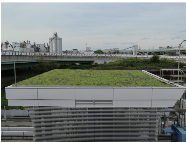
写真4-3-3 4号東海線船見料金所の屋上緑化
