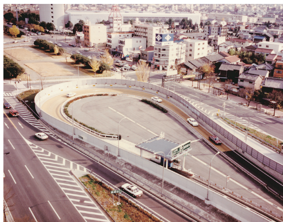
写真2-5-2 吹上暫定連絡路
