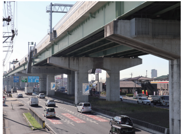
写真2-7-1 16号一宮線の橋脚
