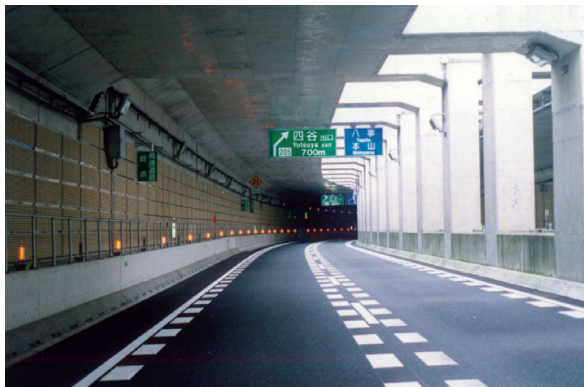
写真2-5-3 半地下区間における壁面吸音板の設置
