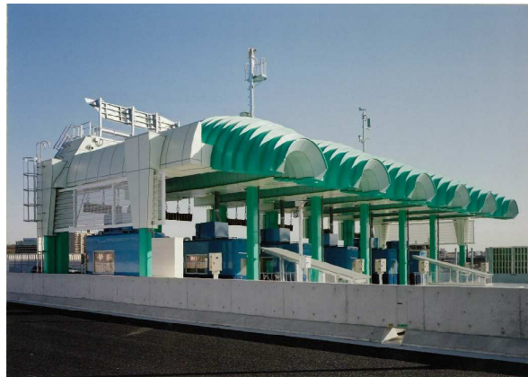
写真2-5-4 高針本線集約料金所
