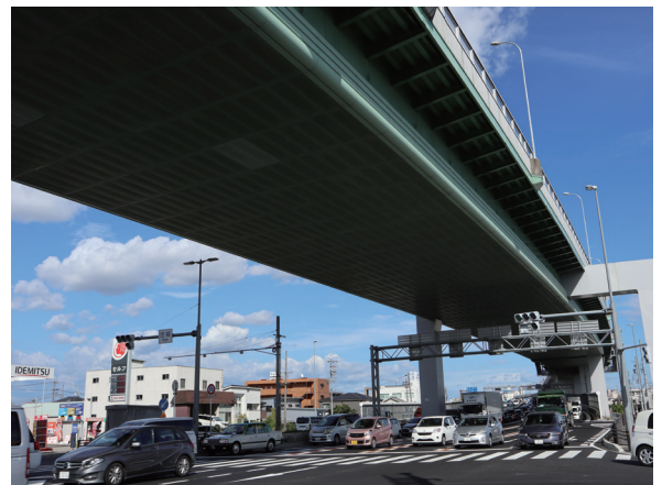
写真2-8-3 古城交差点付近の高架裏面吸音板
