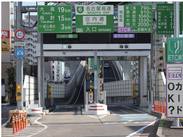
写真2-8-2 庄内通料金所（センターブース方式）
