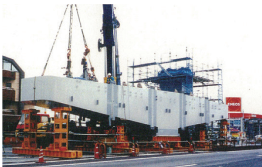
写真2-7-3 橋脚梁の架設準備（昼間）
