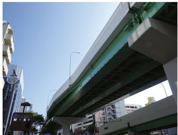
写真2-2-1 ルーバー撤去前（上）とルーバー撤去後の状況
