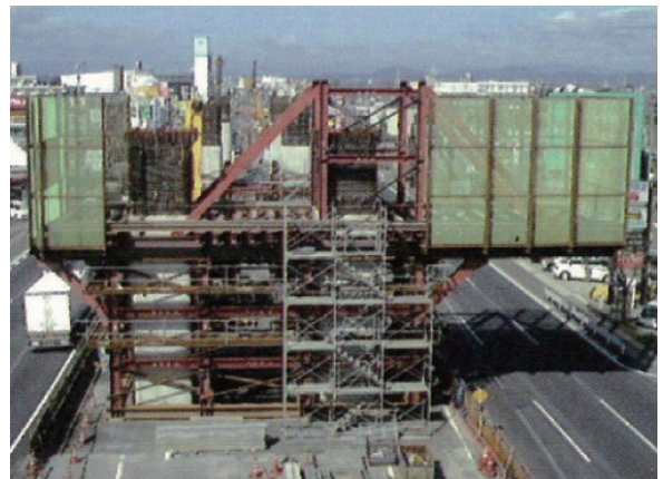
写真2-7-2 橋脚梁支保工
