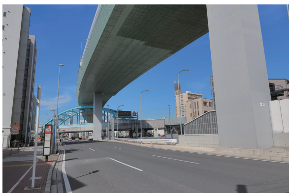
写真2-9-3 六番町の高架裏面吸音板
