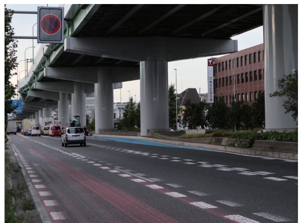
写真2-1-2 一般国道1号上の3号大高線
