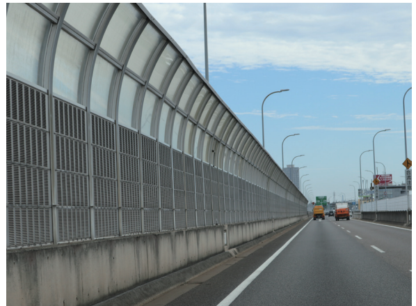
写真2-6-2 豊山地区の特殊遮音壁
