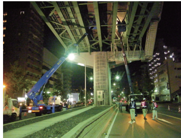
写真5-3-1 高所作業車を用いた目視点検
