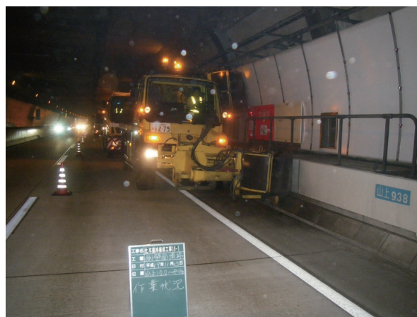
写真5-2-2 トンネル壁面清掃
