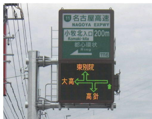
写真5-5-4 入口誘導案内標識（改良後）
