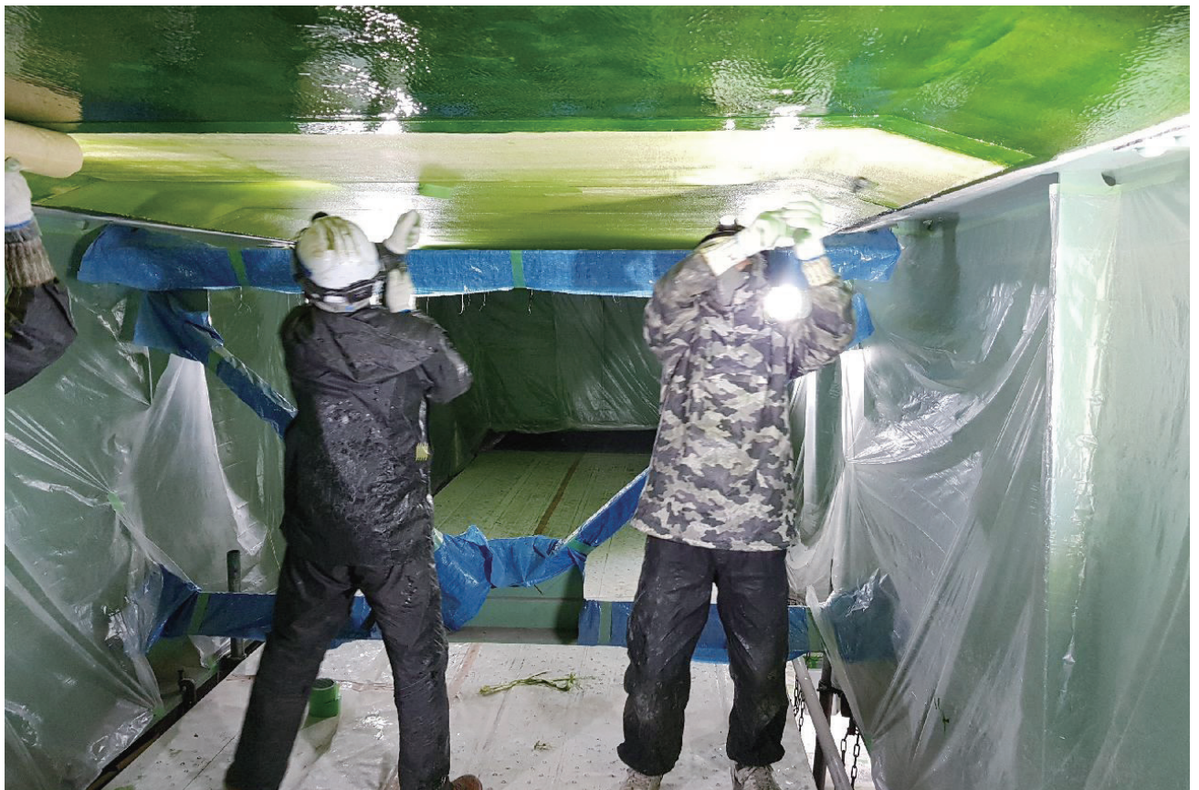
大規模修繕工事の様子
