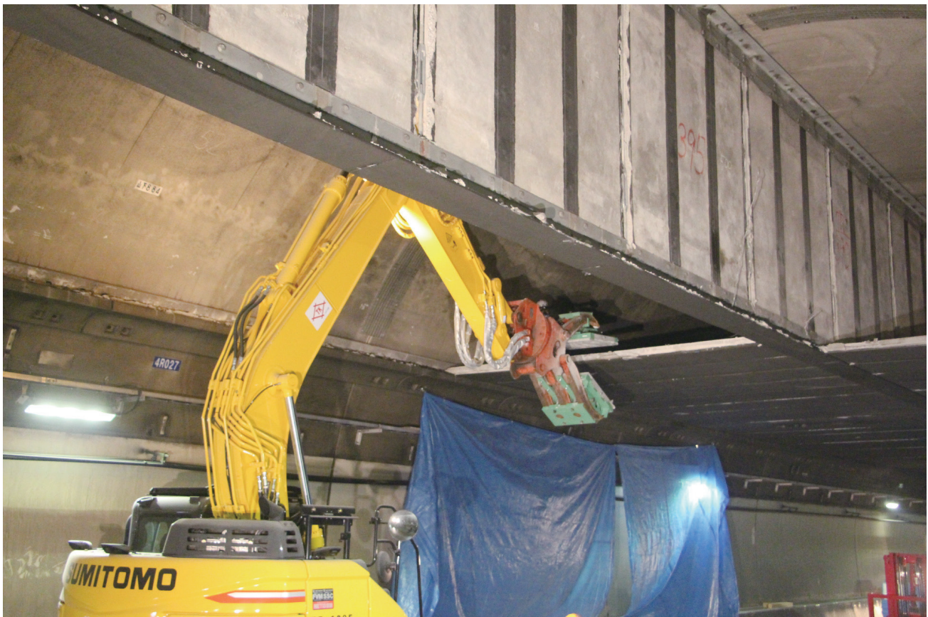
天井板撤去の様子
