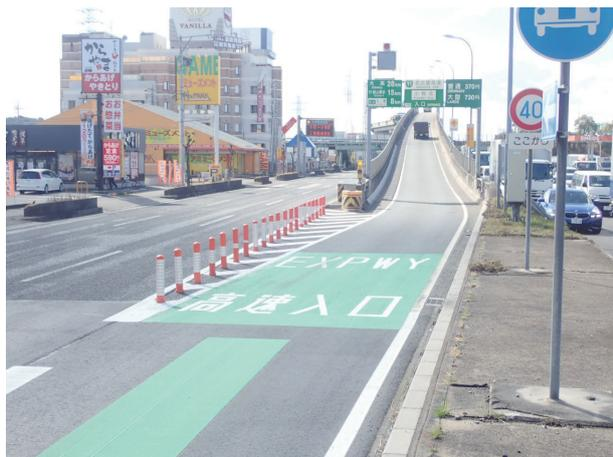
写真8-1-3 路面標示とカラー舗装による誤進入対策
