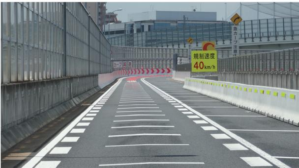
写真8-1-2 減速路面標示等の施工 (高針JCT Cランプ)
