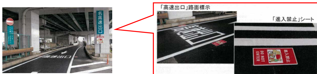
図18 路面標示設置(千音寺出口)
