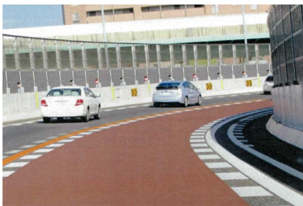
図16 カラー舗装(東片端JCT南カーブ)
