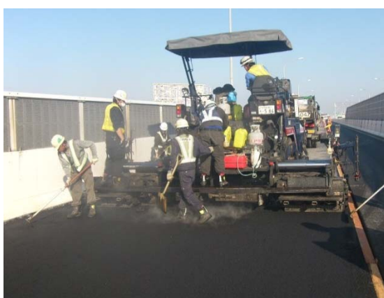
図26 リフレッシュ工事状況
