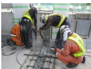
補修工事 (高速3号大高線)
