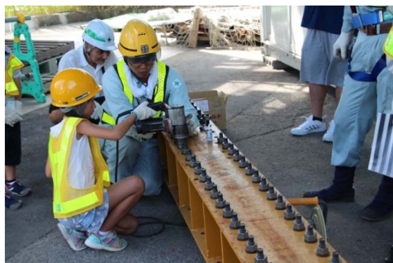
図29 建設現場見学会 (H29.8.4) (ネクス・プラザ夏休みフェスティバル)
