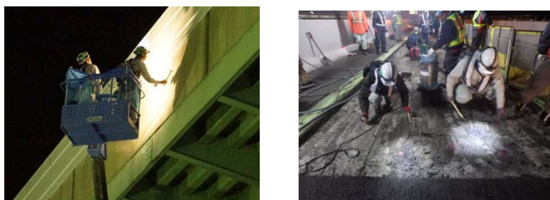
図31 定期点検状況と修繕状況
