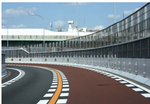
図17 カラー舗装(東片端JCT北カーブ)
