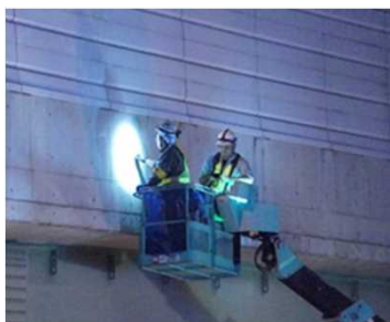
近接目視点検
