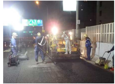
舗装工事実施状況
