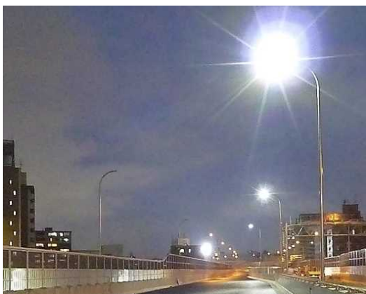
LED照明（4号東海線六番北入口付近）
