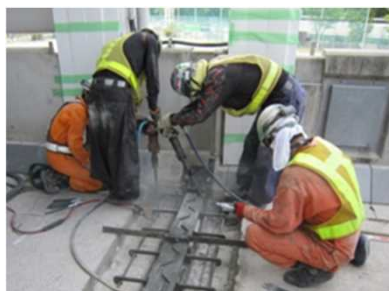
ジョイントの補修
