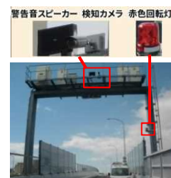
逆走検知・警告システム (吹上東出口)
