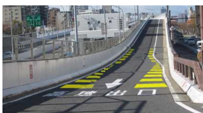
施工イメージ（黄色カラー舗装）
