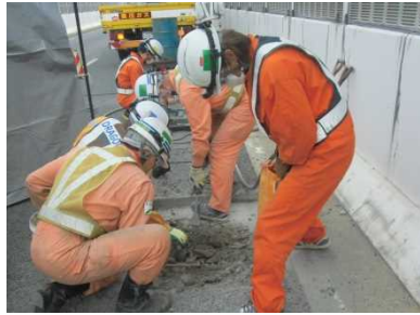
路面の緊急補修
