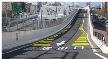
施工イメージ (黄色カラー舗装)
