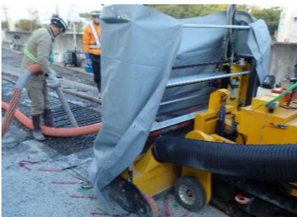
超高圧水による床版はつり（新たな技術の採用）
