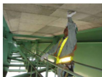
検査路によるRC床版の 近接目視点検の状況
