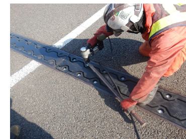
伸縮装置の修繕
