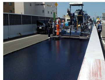
アスファルトの舗設
