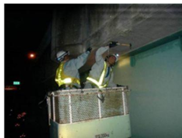
高所作業車によるRC床版の 打音検査の状況
