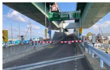
入口閉鎖装置設置例
