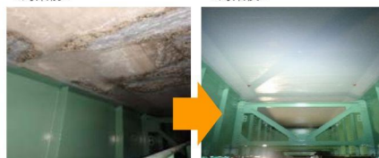
大規模修繕の対策例（コンクリート床版下面）
