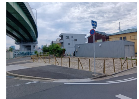
用地取得が進み木柵で囲んだところ
