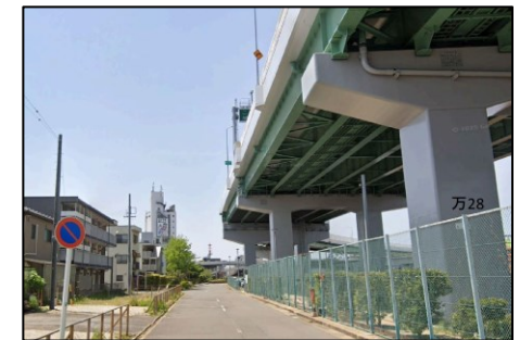
工事に着手する前の現在の様子
