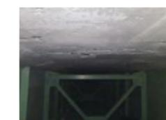
コンクリート床版が走行車両の影響を受けて、繰り返したわむむことで、ひび割れが発生及び進展していきます。
