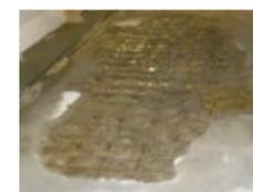
コンクリート床版内部に雨水等が浸透したことにより、鉄筋の腐食、コンクリートの劣化・損傷が顕在化しています。
