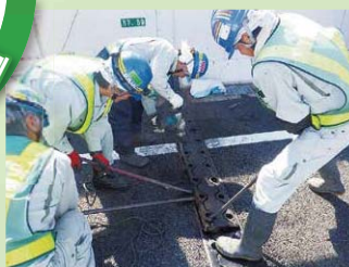
<伸縮装置補修工事>
