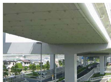
高架裏面吸音板 (高針JCT付近)
