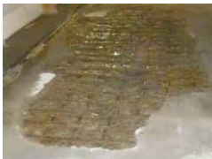
コンクリートの損傷・鉄筋腐食
