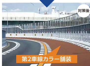
カラー舗装の事例(東片端JCT北カーブ)
