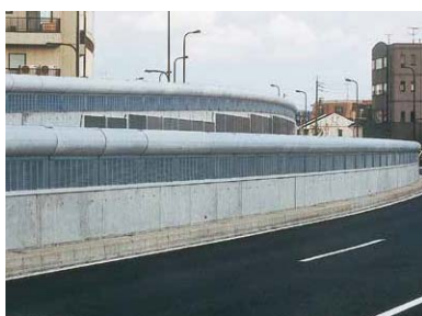
先端改良型遮音壁 (2号東山線南明町付近)
