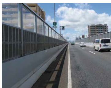
通常遮音壁 (1号楠線萩野付近)
