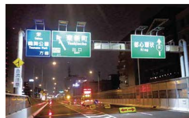
同一規制内での工事
