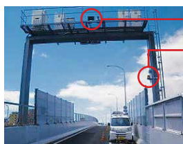
逆走検知・警告システム(吹上東出口)
