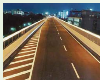
都心環状線 (明道町JCT～東片端JCTの一部区間)
