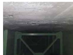
格子状(2方向)のひび割れ
