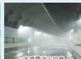
水噴霧消火設備
