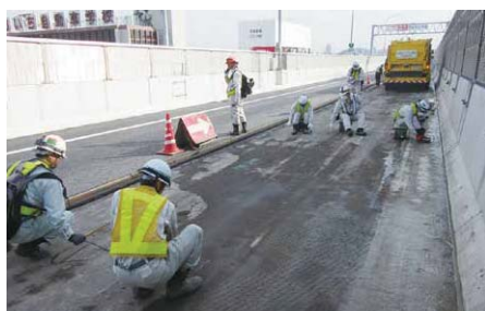
リフレッシュ工事の状況
